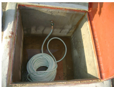
Figura 15: Arranque para riego 1x1x1m.
