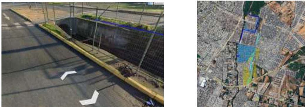
Ilustración 15: Ejemplos de sectores de anegamientos productos de fallencias estructurales en el drenaje
