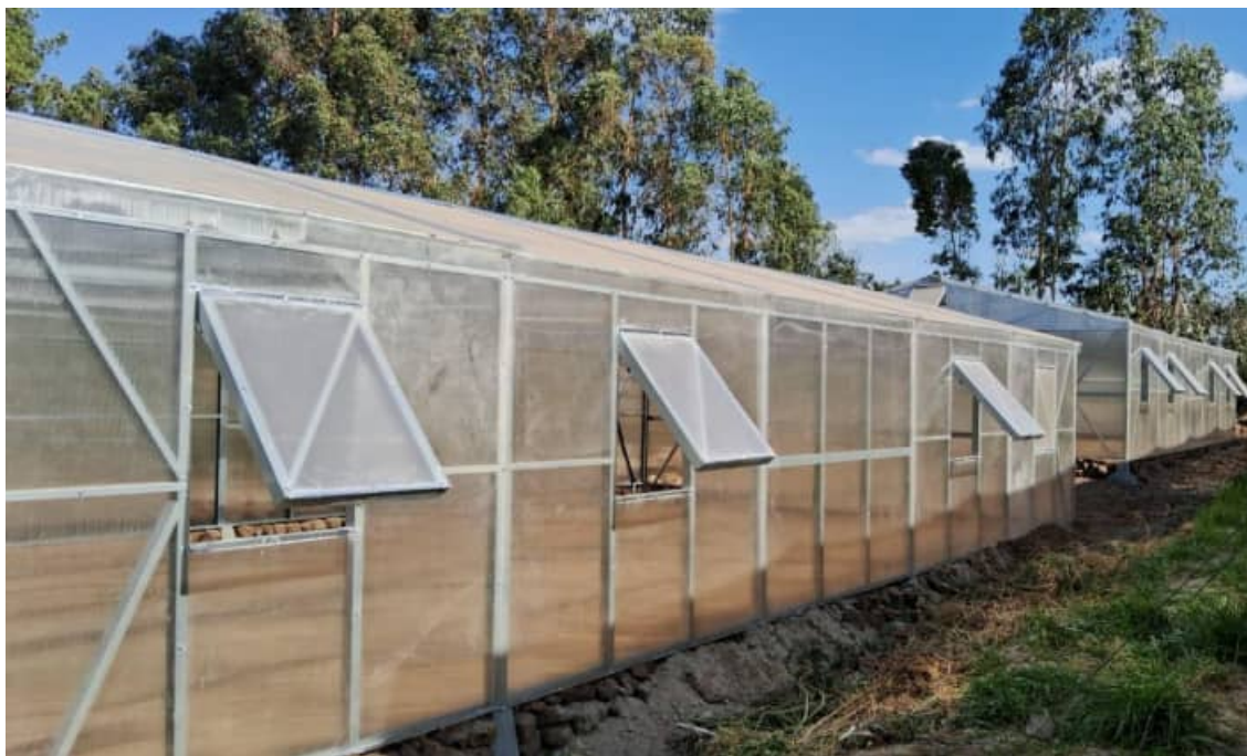
Proyecto CNR de riego con panel fotovoltaico e invernadero metálico
